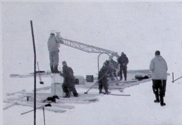
Montaggio del derrick (1° gennaio 1961)
